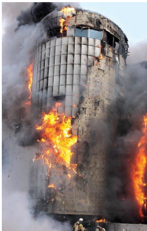
Фото 11. Пожар в здании ледового дворца, г. Сургут
