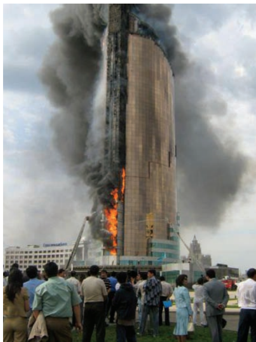
Фото 8. Пожар в административном здании «Транспорт-Тауэр», г. Астана
