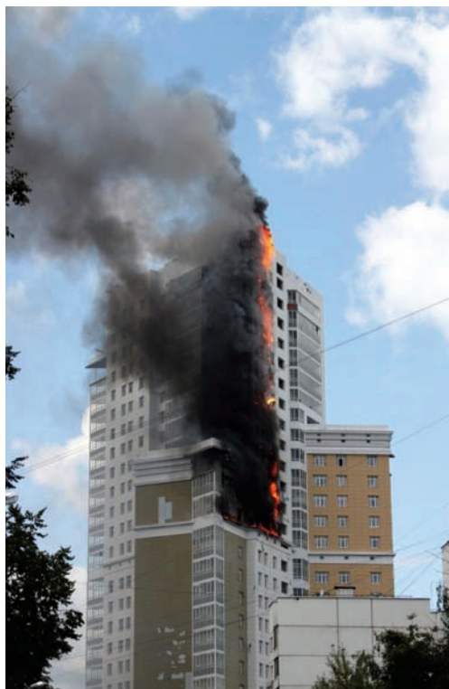
Фото 10. Пожар в жилом комплексе «Вектор-Хаус», г. Москва
