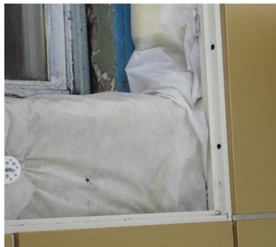
Фото 3. Отсутствие вентиляционного зазора
