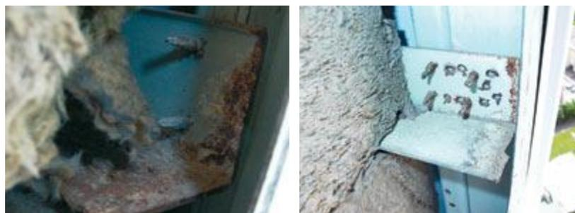
Фото 3, 4. Навесная фасадная система с воздушным зазором и облицовочным слоем из фиброцементных плит. При монтаже плит облицовки в качестве инструмента для закручивания саморезов использовались дрели, не имеющие ограничителя затягивающего усилия, со скоростью вращения 3 000–5 000 об./мин. В результате этого было повреждено оцинкованное покрытие самонарезающих винтов крепления, и спустя менее чем 1,5 года наблюдается интенсивное развитие коррозии.
