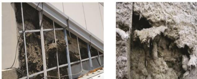
Фото 4. Деструкция минераловатного утеплителя
