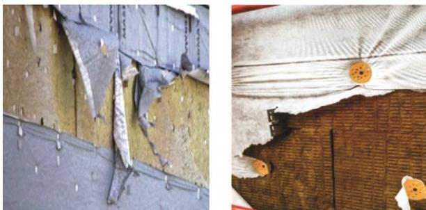
Фото 3. Повреждения ветрозащитной пленки в процессе выполнения монтажных работ
