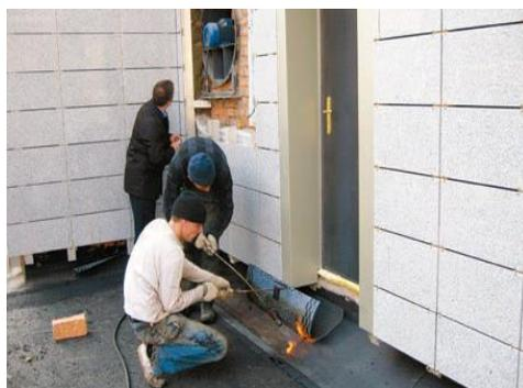
Фото. 2. Огневые работы при наплавлении гидроизоляции
