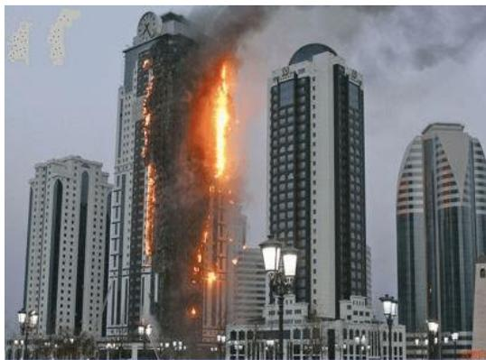
Фото 2. Пожар на фасаде башни «Олимп» комплекса «Грозный-сити», облицованной сильногорючими алюминиевыми композитными кассетами (2013 г.)
