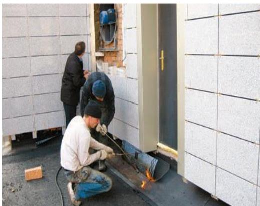
Фото 1. Огневые работы при наплавлении гидроизоляции вблизи нижнего продуха НФС
