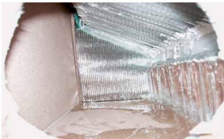
**Рисунок 5.1 – Замерзший конденсат в камере удаляемого воздуха рекуперативного теплообменника**
